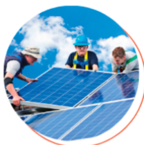
Instalação de Painéis Solares
